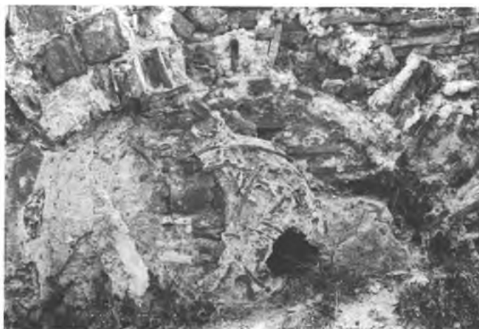
Илл. 57. Фатих Джами, Энезе. Кладка северного фасада жертвенника. Фотография Р. Оустерхаута [41, fig. 9]
